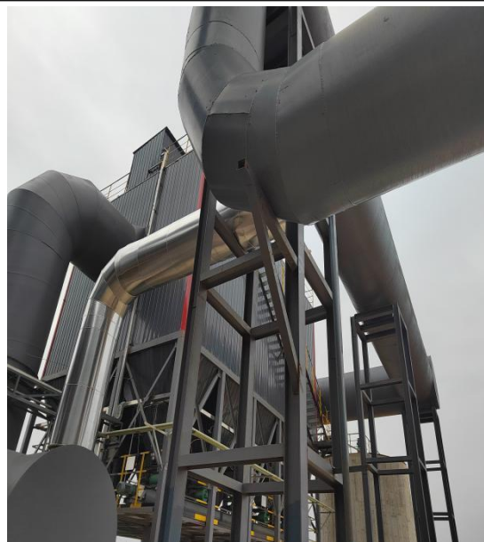
“耐高温布袋除尘器+石灰-石膏法脱硫”设施、废气排口 DA083
