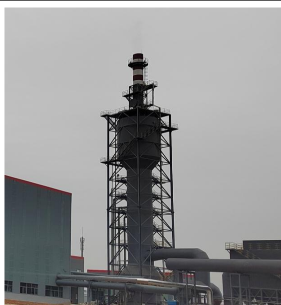
“耐高温布袋除尘器+石灰-石膏法脱硫”设施、废气排口 DA083
