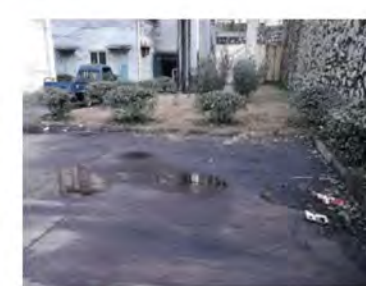
▲问题图片（储运公司焦场北侧入口）：现场环境卫生差，废弃物随意丢弃。扣罚葛贝鲁100元
