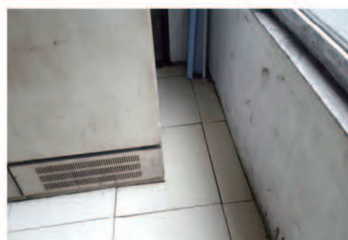
▲整改后图片(储运公司一期破碎 室): 完成
