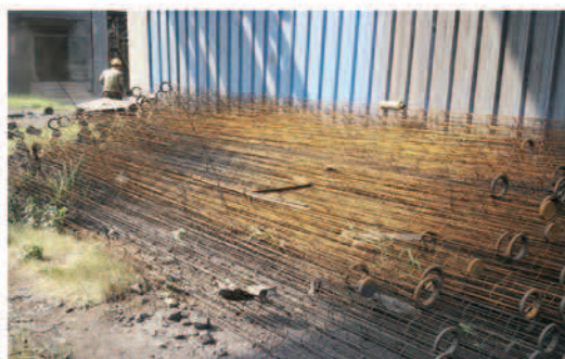
▲问题图片(储运公司焦7皮带机头下方 地面): 废弃杂物未清理处罚中石机电200元 (二次处罚)
