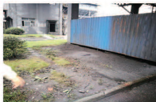
▲整改后图片(储运公司焦7皮带机 头下方地面): 完成
