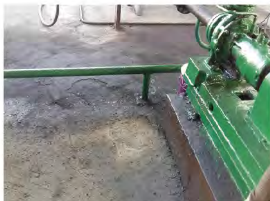
▲整改后图片（化产分厂冷鼓工段）：完成
