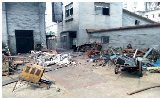
▲问题图片（天奇蓝天维修班入口处）：室外废弃塑料袋、其余杂物未清理。处罚100元
