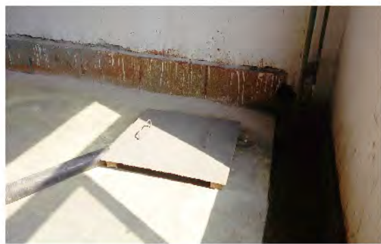
▲整改后图片（化产分厂生化工段）：完成
