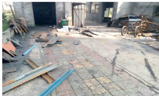
▲整改后图片（天奇蓝天维修班入口处）：完成
