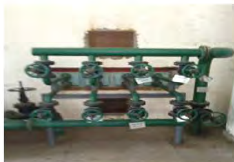
▲现场整改后图片（动力分厂1#-3#汽机厂房）：完成整改项。
