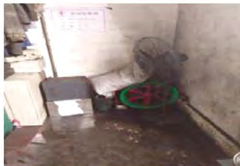
▲现场整改后图片（储运中石电工维修班）：完成整改项。
