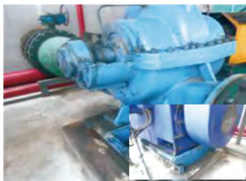
▲现场整改前图片（动力分厂煤压循环水泵）：完成整改项。
