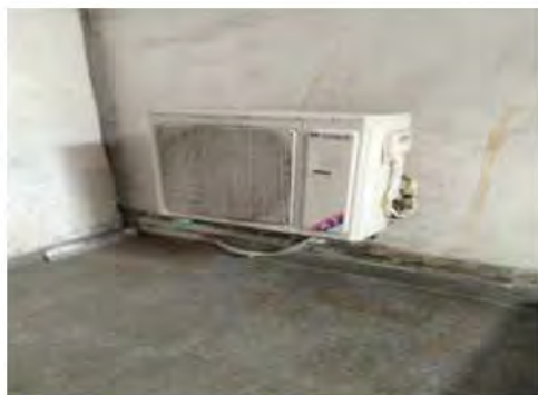
▲现场整改后图片（动力分厂1#-3#汽机房）：完成整改项。
