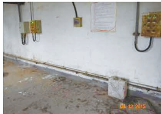
改善后图片（动力分厂除盐水区域）：现场清理干净，无不要物堆放；后期需进行墙面粉刷、地面锈迹处理等措施改善现场环境 ▲
